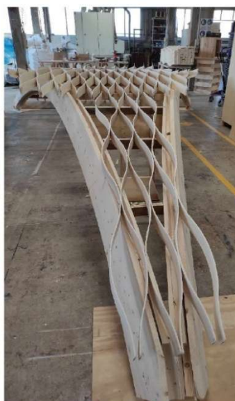
Lavorazioni in corso per assemblaggio maglie alveolari
